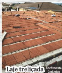
Laje treliçada Enchimento Cerâmico
